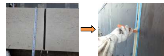
シール打替・補修
